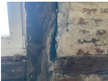
Geschädigtes Giebfachwerk
