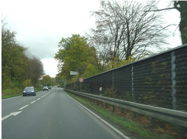
Weiterhin besteht ein bepflanzter Lärmschutzwall im Ortsteil Hachmühlen an der Ostseite der B 442 im Bereich zwischen den Grundstücken „Auf der Laake 30“ und „Auf der Höhe 2“ (südlich der Einmündung Auf der Höhe). Der Lärmschutzwall endet an einem sich südlich anschließenden Fußgänger- und Fahrradweg.<sup>42</sup>
